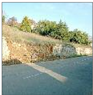
Le mur est situé sous un terrain en pente (Photo GB)
